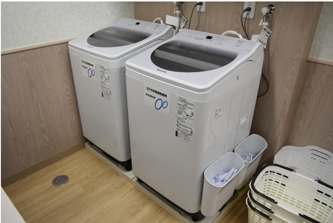
<洗濯機（補助対象初度調弁）>
